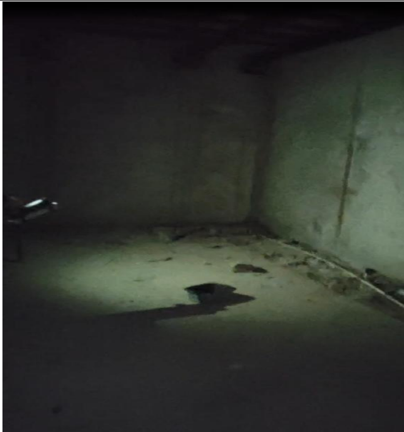
本项目 DSA 机房现状图
